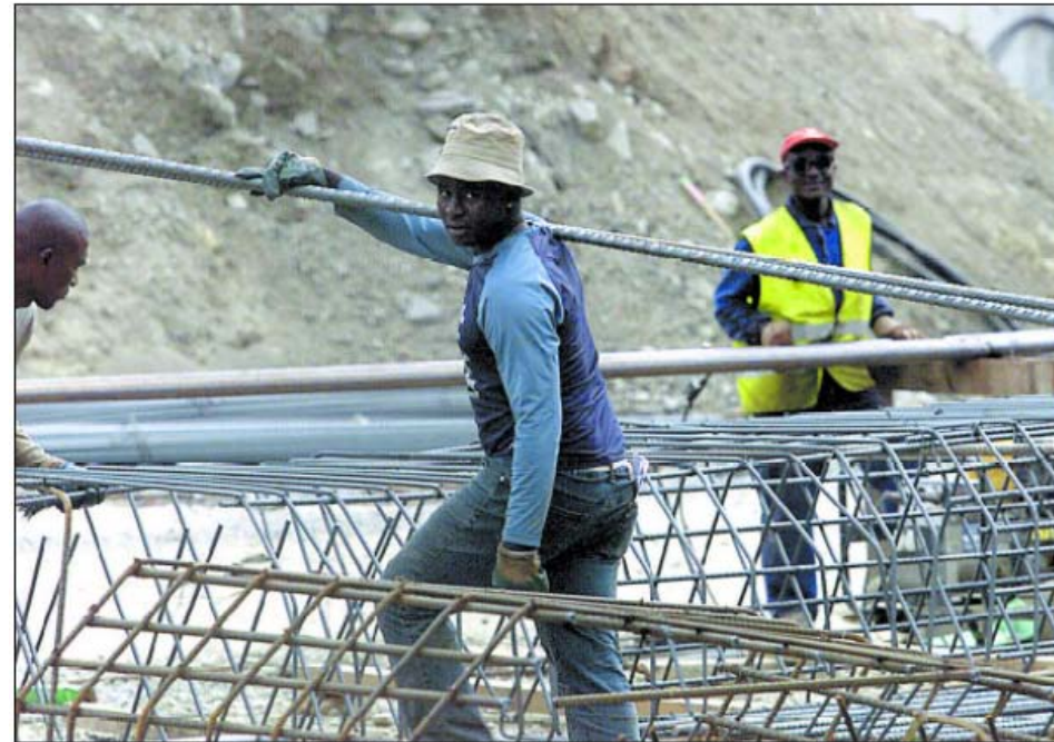
Trabajadores extranjeros en las obras de Abandoibarra en Bilbao. / SANTOS CIRILO
