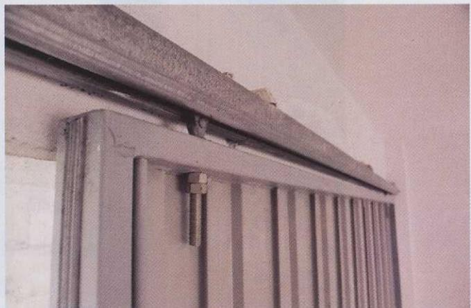
Fig. 14. Fijación de los mecanismos de cuelgue y guía.
