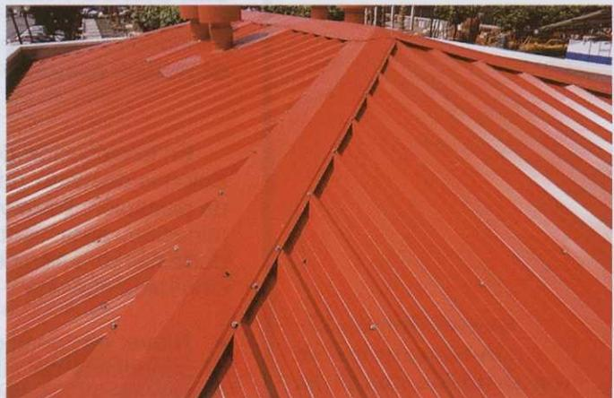
Fig. 18. Tejado de chapa galvanizada.
