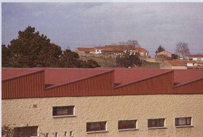
Fig. 8. Cubierta en diente de sierra.
