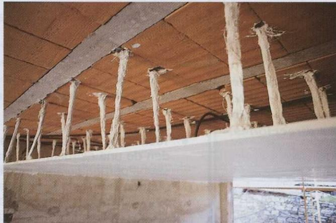
Fig. 4. Techo continuo de plancha de escayola.
