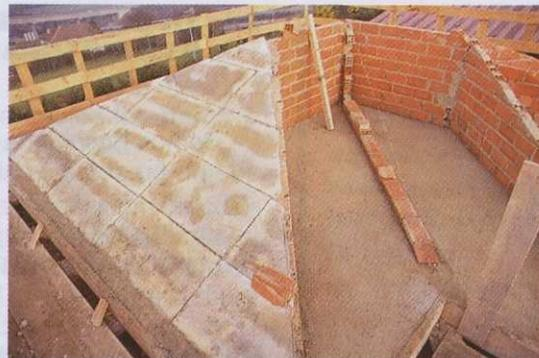
Fig. 19. Cubierta de albañilería.
