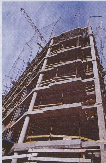
Fig. 10. Protecciones colectivas.
