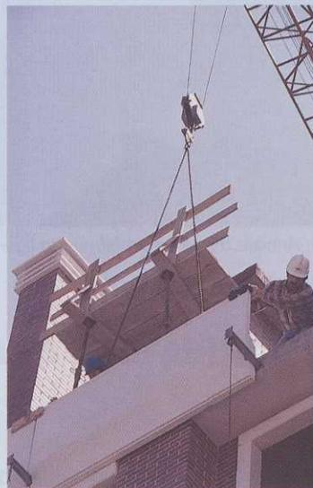
Fig. 13. Fases de elevación del panel.
