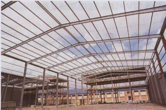
Fig. 18. Cubierta de armadura.
