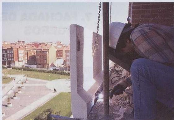
Fig. 9. Anclaje de panel prefabricado pesado.
