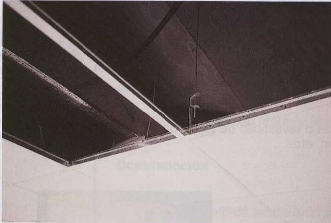
Fig. 12. Techo de placas acústicas conglomeradas.
