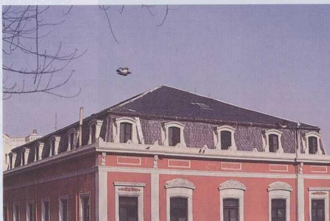
Fig. 7. Cubierta mansarda.
