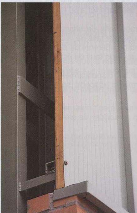
Fig. 11. Anclaje de panel prefabricado ligero.
