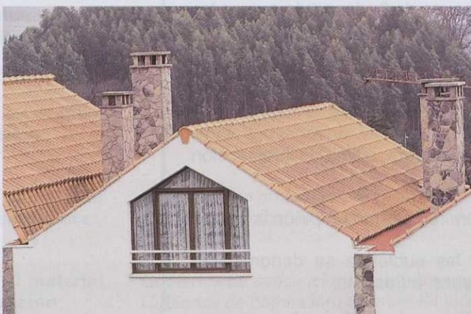
Fig. 5. Cubierta a dos aguas.
