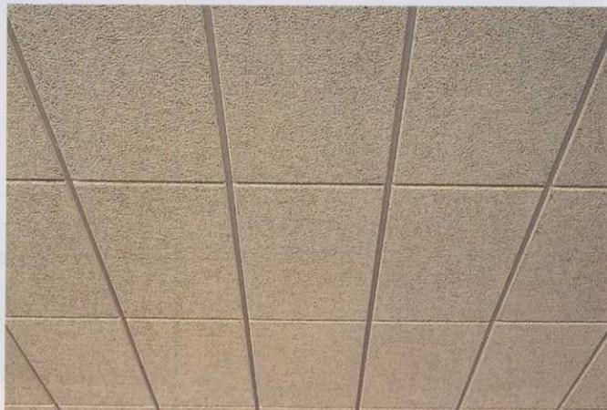
Fig. 13. Techo de placas acústicas de fibras vegetales.
