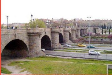
Puente de Toledo Madrid
