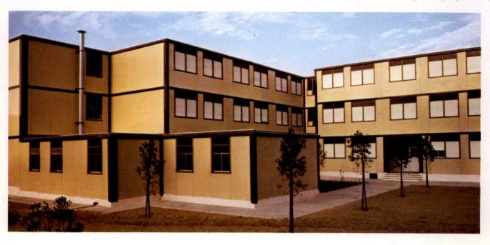
neles «sandwich» de mortero de poliéster armado, unidos entre sí mediante elementos de cierre excéntrico. Estos grandes paneles iban colgados de la estructura, tipo muro cortina.
