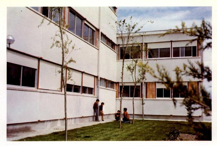
yas ventajas son conocidas y entre las que cabe destacar su alta resistencia a la flexotracción y al impacto, así como su incombustibilidad e inalterabilidad frente a los ciclos de hielo-deshielo y a la agresividad de otros agentes atmosféricos. El trasdosado de la lámina de G.R.C. se hace con hormigón ligero, beneficiándose de las ventajas de éste respecto a los aislamientos acústicos y térmicos.
