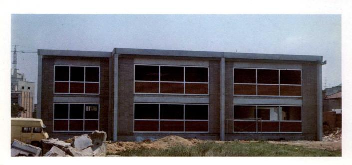
previstos en la cimentación y que dispone de ménsulas para apoyo de las vigas. Las jácenas apoyadas en las ménsulas de borde y continuas en las centrales, reciben los paneles, hormigonándose en obra la cabeza comprimida de la viga, la capa de compresión de los forjados y el nudo con los pilares. En fachadas laterales se han previsto zunchos de hormigón armado correspondientes al borde del forjado, que enlazan transversalmente los entramados longitudinales.
