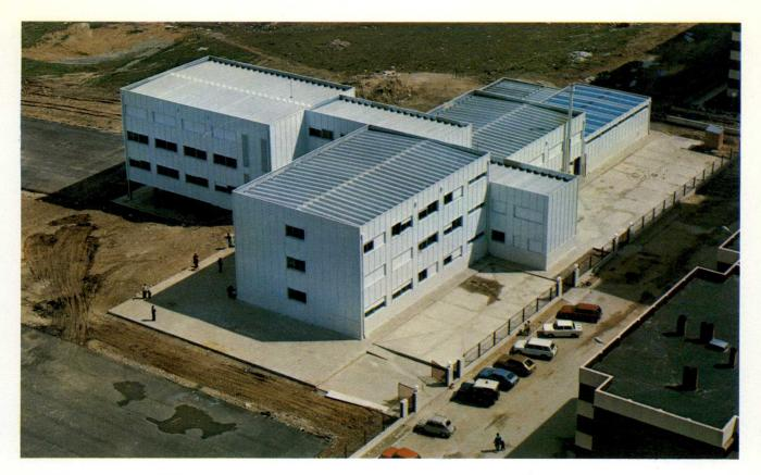
diante una estructura metálica con base en la cimentación que requiera el terreno. Dicha estructura va provista de una doble protección antioxidante y antifuego, pudiendo realizarse su montaje por medio de soldadura o atornillada. Su cálculo se realiza de acuerdo con las normas del Ministerio de la Vivienda español y adaptadas a las condiciones de la zona de utilización (desértica, sísmica, etc.).
