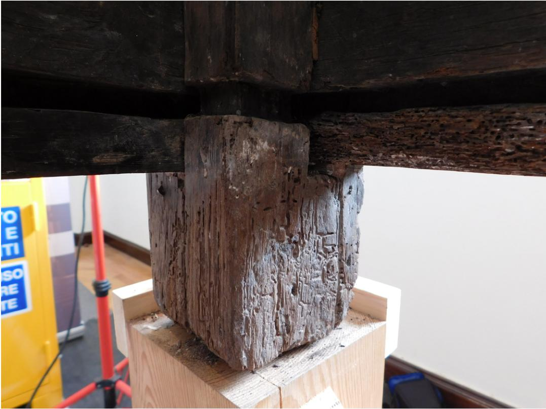
**Figura 1.6.** Cajón de madera. Detalle de la unión peinazos-barrote. Fotografía: Abel Vega Cueto.
