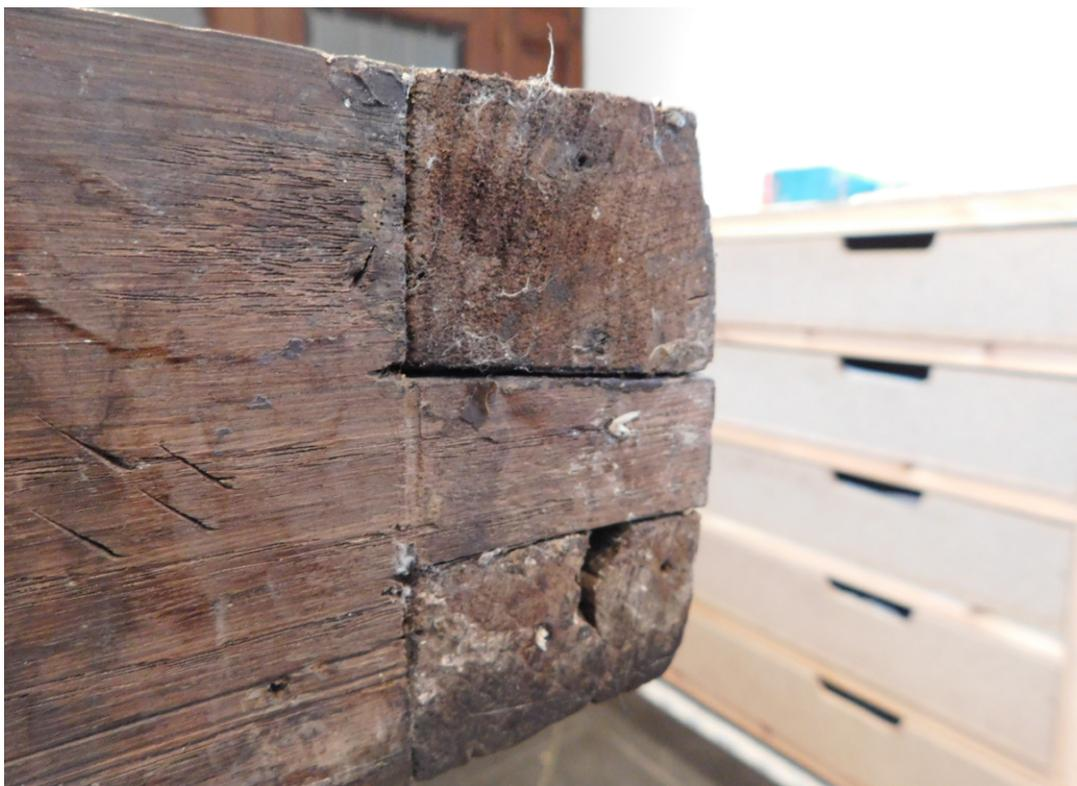
**Figura 2.2.** Cajón de madera. Detalle del ensamble entre largueros. Fotografía: Abel Vega Cueto.
