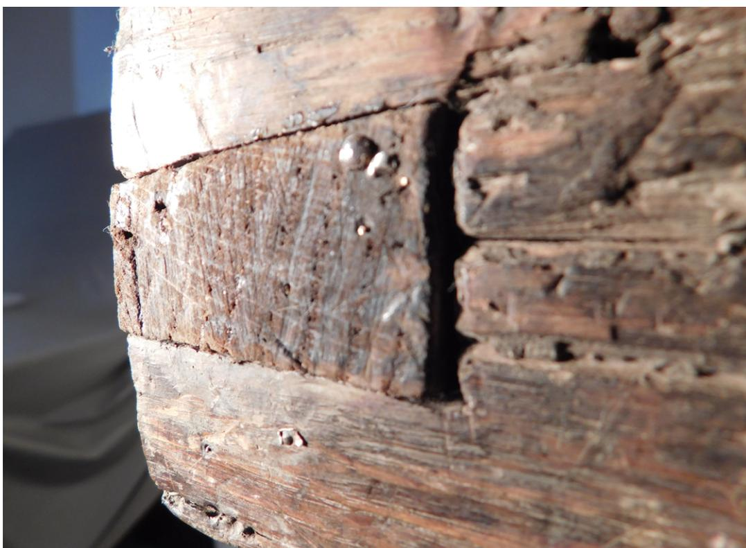
**Figura 2.3.** Cajón de madera. Detalle del ensamble entre largueros (cola de milano). Fotografía: Abel Vega Cueto.
