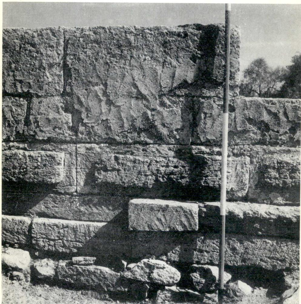
*Detalle del aparejo del gran muro almohadillado. Obsérvese una zona con revestido*
