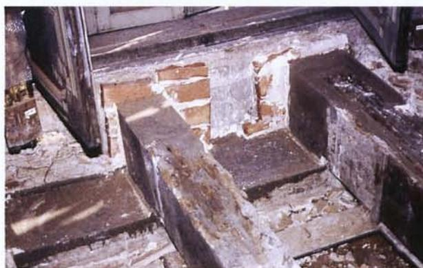
Figura 10. Restitución de la sección de las vigas por inyección de resinas epoxídicas en el forjado de la planta noble.
