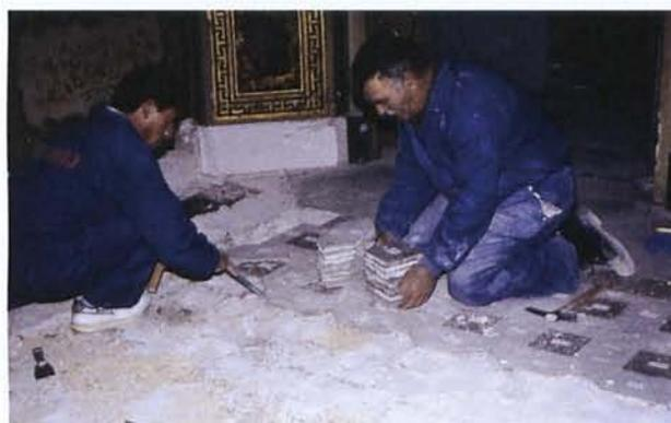
Figura 9. Desmontaje de los pavimentos de mármol de la planta noble.
