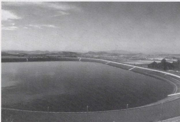
Posteriormente a la construcción de la depuradora y dentro del plan de modernización de los regadíos de Bullas se construyó, a nivel superior, un embalse con capacidad para 100.000 m.<sup>3</sup> con la finalidad de almacenar las aguas ya depuradas para su posterior utilización en el regadío.
