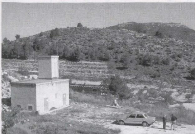
Sondeo explotación realizado en 1980, tras el agotamiento de la fuente de la Rafa. Está situado en la Loma de las Atalayas sobre el acuífero el Charco, a una altitud de 680 metros sobre el nivel del mar. Tiene una profundidad de 196 metros y un aforo de 100 litros por segundo. Actualmente es el principal recurso hídrico para el regadío de Bullas.
