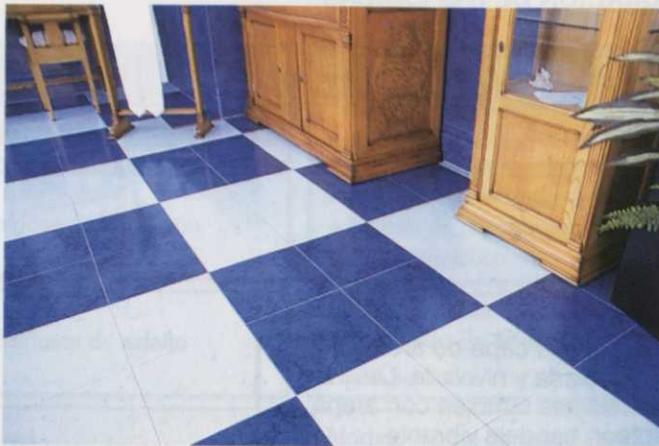
Fig. 10. Pavimento de baldosa de gres.
