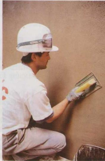
Fig. 4. Albañil enfoscando.
