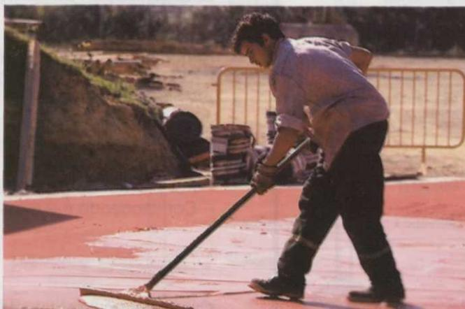
Fig. 12. Pavimento continuo de resinas sintéticas.
