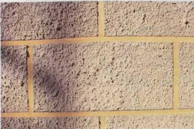
Fig. 9. Revoco tendido con mortero cemento.
