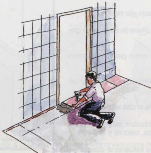
Fig. 7. Inicio colocación pieza de embaldosado.
