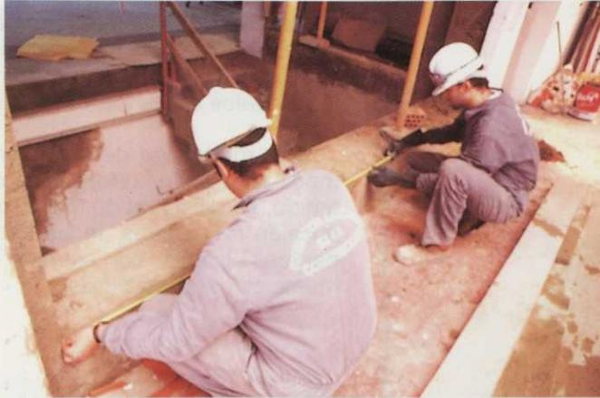
Fig. 2. Medición de un paramento.
