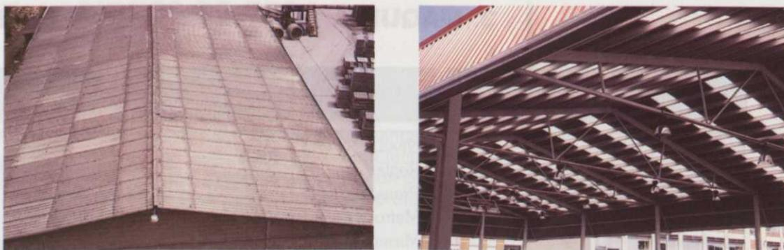
Fig. 22. Tejado de fibrocemento y tejado de plancha sintética.
