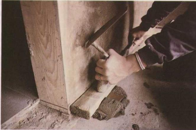
Fig. 22. Empañado de regla para obtención de nivel de arranque de azulejo.
