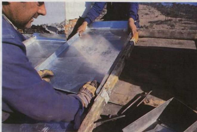
Fig. 8. Operario colocando cubierta.
