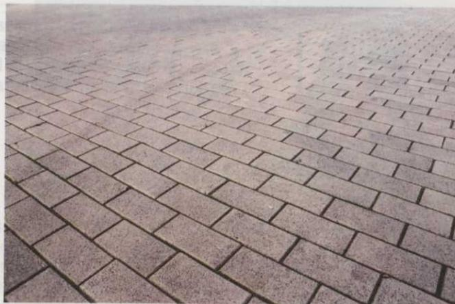
Fig. 9. Pavimento de bloques de hormigón.
