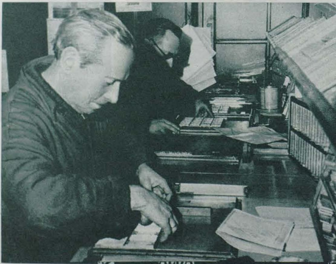
Estos operarios se llaman ajustadores, porque ajustan las páginas de la revista sobre esa mesa metálica llamada platina. Cuando los linotipistas componen en plomo el original correspondiente a cada trabajo, se lleva a una pequeña máquina, de la que se sacan pruebas, y el plomo pasa a la platina.
