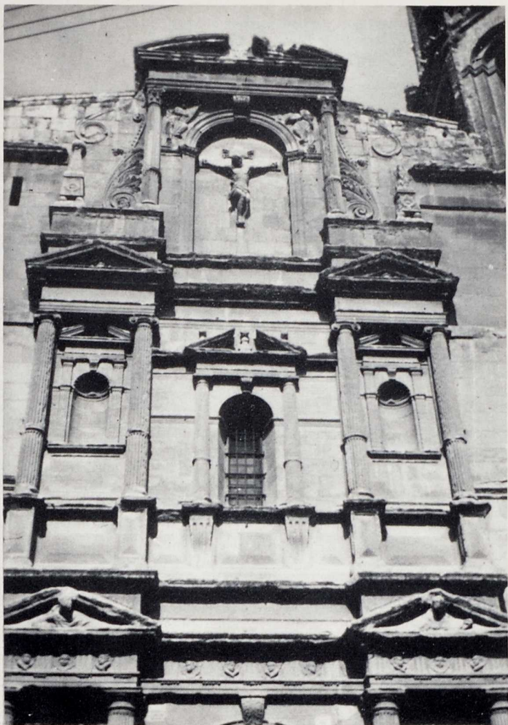
19. ANDORRA.—Fachada de la parroquial (Cañada).
