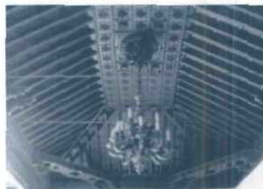
Armadura de Par y Nudillo. Palacio Salazar, S/C de La Palma
