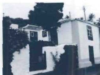
Vivienda con planta en forma de L y que se adapta perfectamente a los desniveles del terreno. Breña Baja
