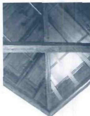
Armadura de limabordón.
