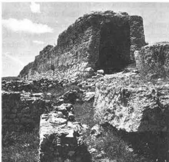
Extremo oriental de la muralla republicana, en la que se puede observar la técnica constructiva con una base de piedra y un cuerpo de hormigón encofrado.
