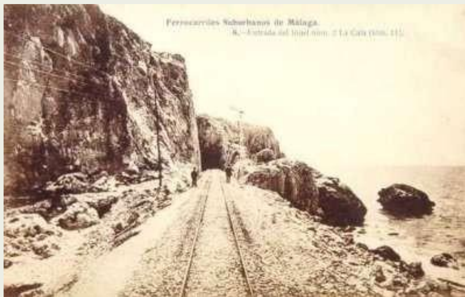
Imagen 1 Túnel construido en 1907 para el paso del tren. En él se refugiaron los civiles que iban a Almería, y que fue bombardeado. Archivo fotográfico
